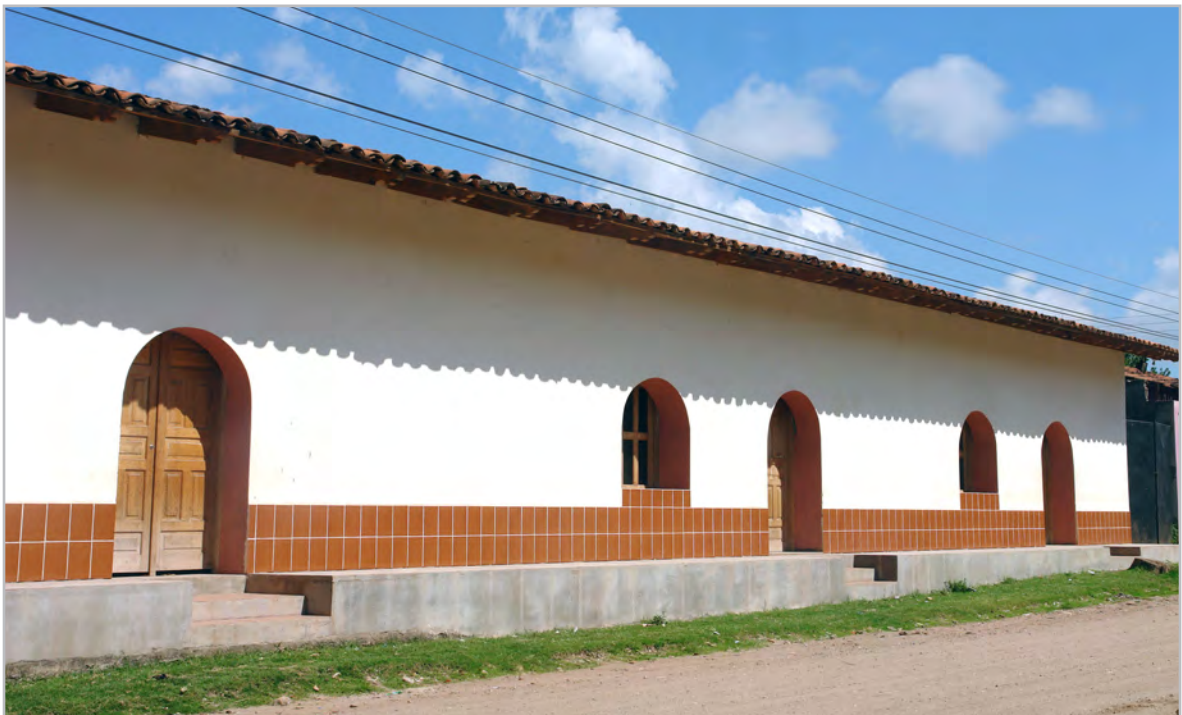
En esta casa anteriormente funcionó la Escuela Marco Aurelio Soto. En la actualidad ha sido reacondicionada para que ocupe La Casa de La Cultura en Gualaco.
