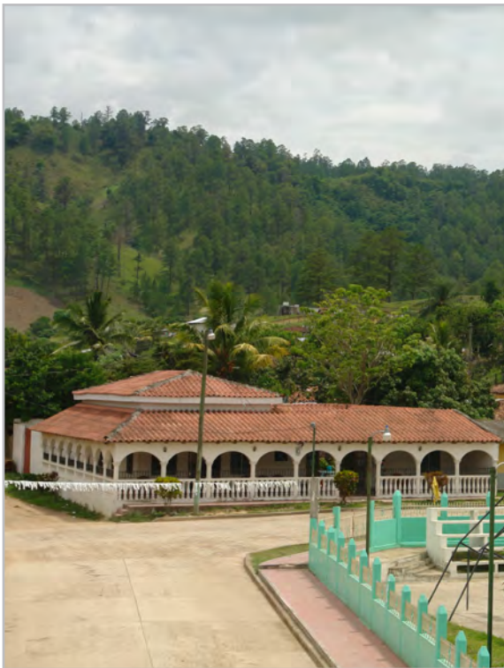
Moderna municipalidad de Jano, frente al Parque Central.
