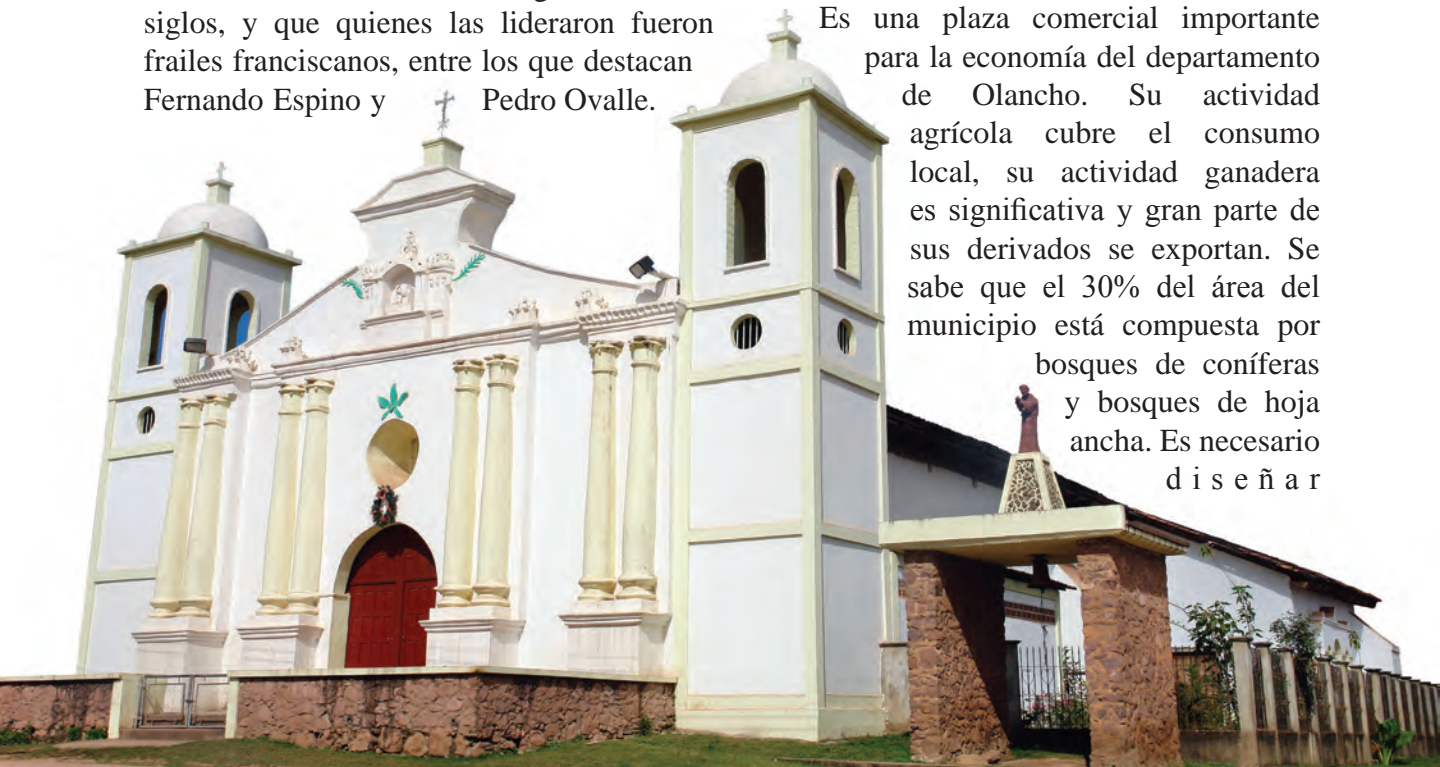
Fachada de la iglesia San Jerónimo de Gualaco. Construida a finales del siglo XVIII.
