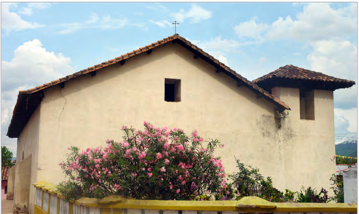
Iglesia de San Juan Bautista, patrón del municipio de Guayape, construida a finales del siglo XIX.
