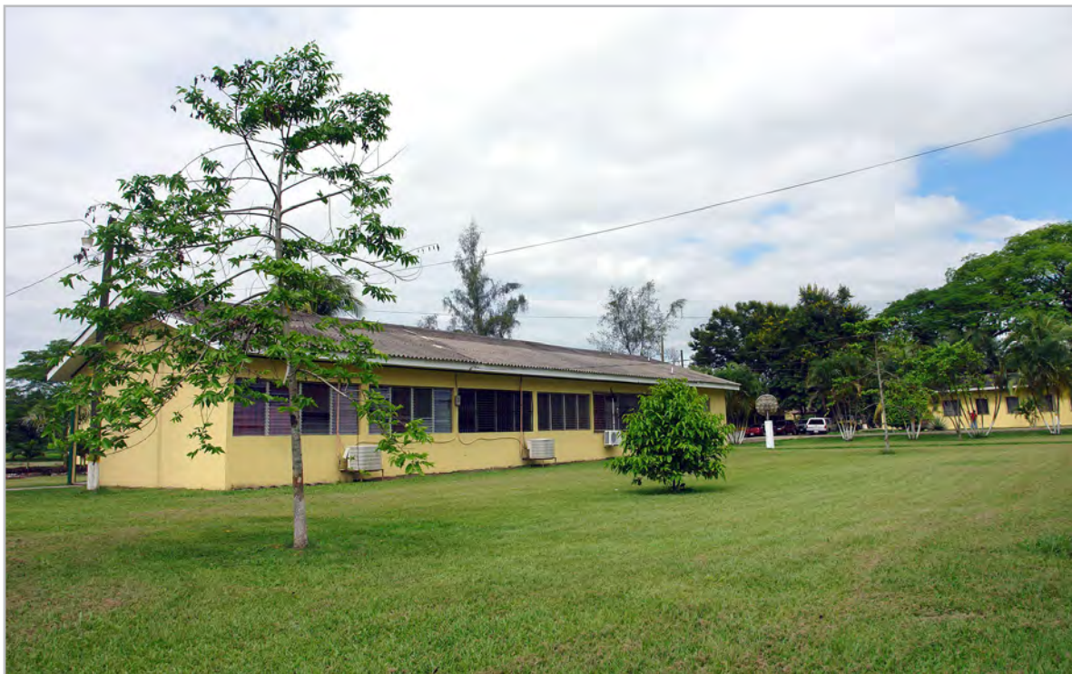
Vista parcial de las instalaciones de la Universidad Nacional de Agricultura.
