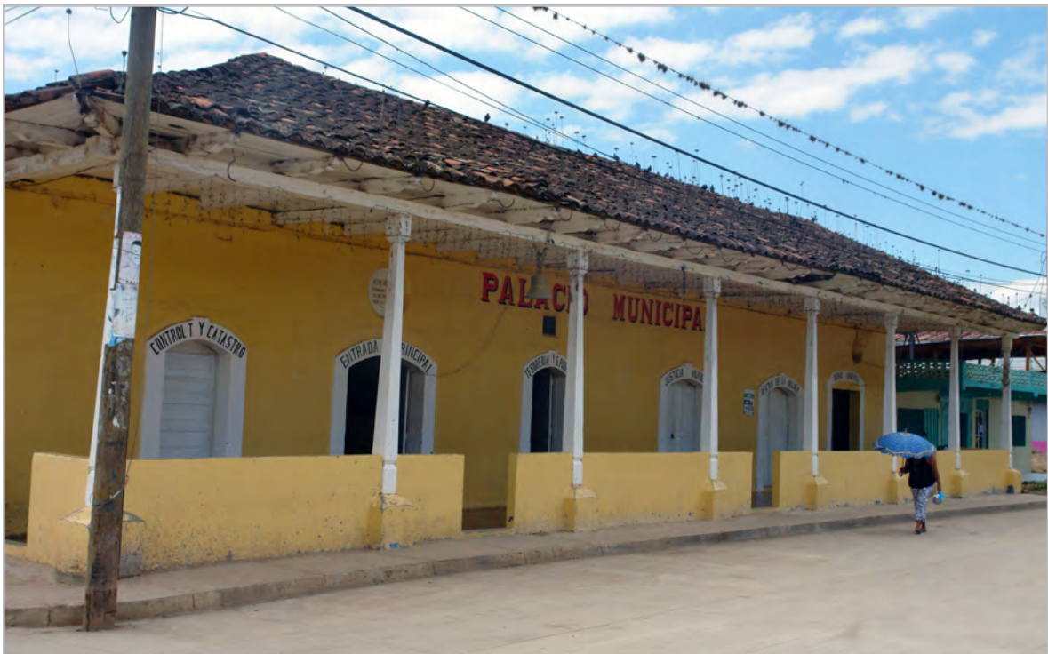
Edificio del Palacio Municipal de San Francisco de la Paz
